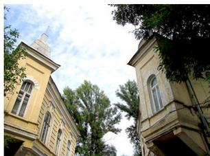
Корпуса Т-образной конфигурации в плане, двухэтажные с подвалом и чердачной крышей кирпичные.
