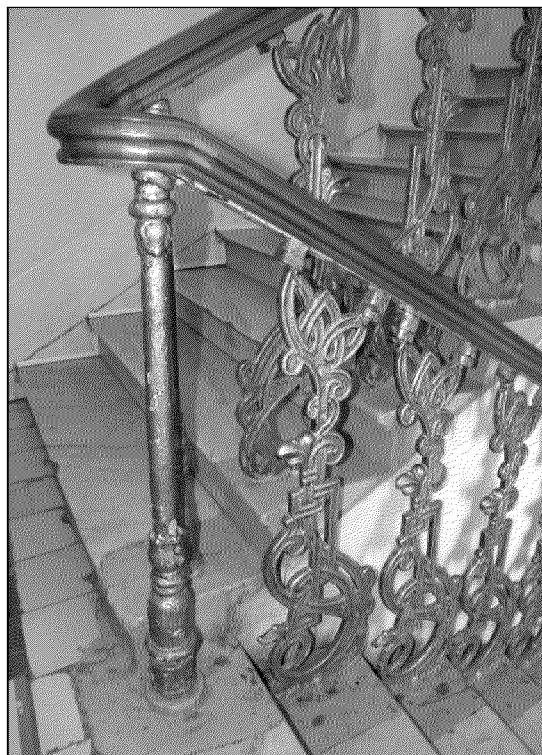
«Главный административный корпус» (внутренняя междуэтажная лестница в северной части)
