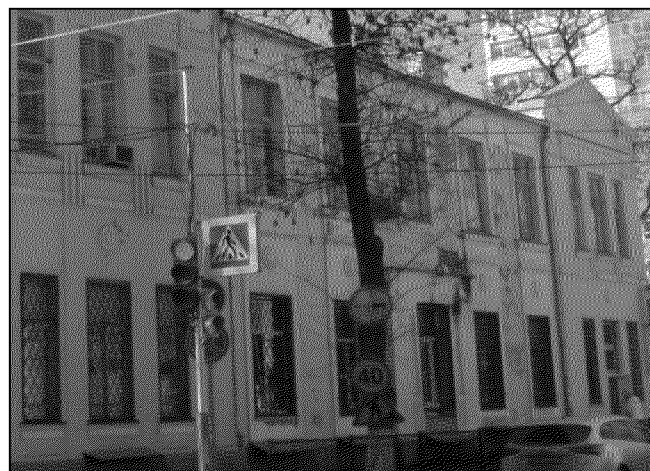
«Двухэтажный корпус» (фрагмент северного фасада);
