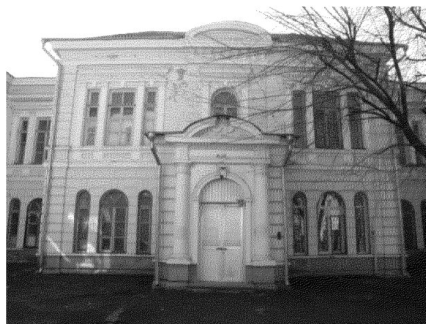
«Главный административный корпус» (фрагмент северного фасада восточной части);
