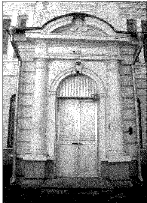
«Главный административный корпус» (фрагмент центрального ризалита восточной части северного фасада)
