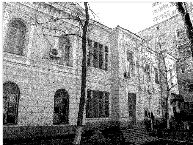
«Главный административный корпус (общий вид западной части северного фасада);
