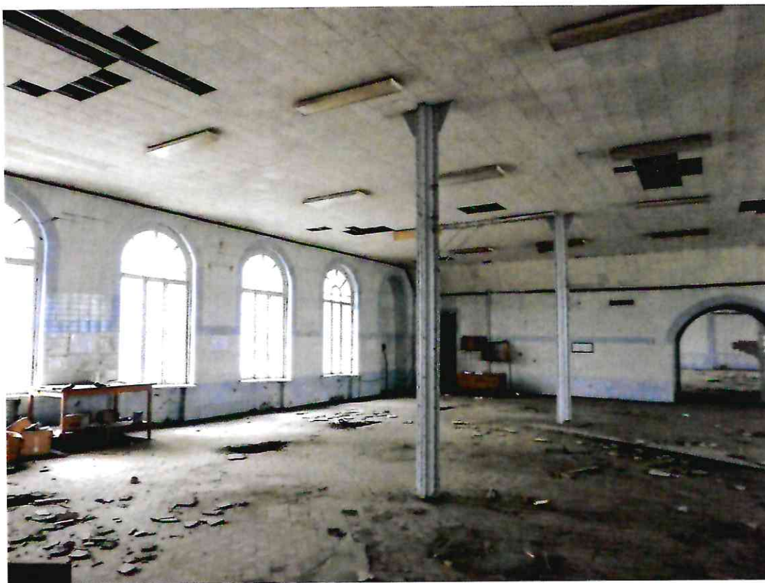
23. Зал 2-го этажа литера А, входящего в состав Объекта.
