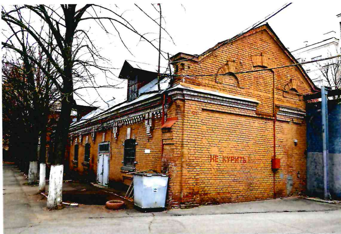
44. Вид с юго-востока литера К, входящего в состав Объекта.
