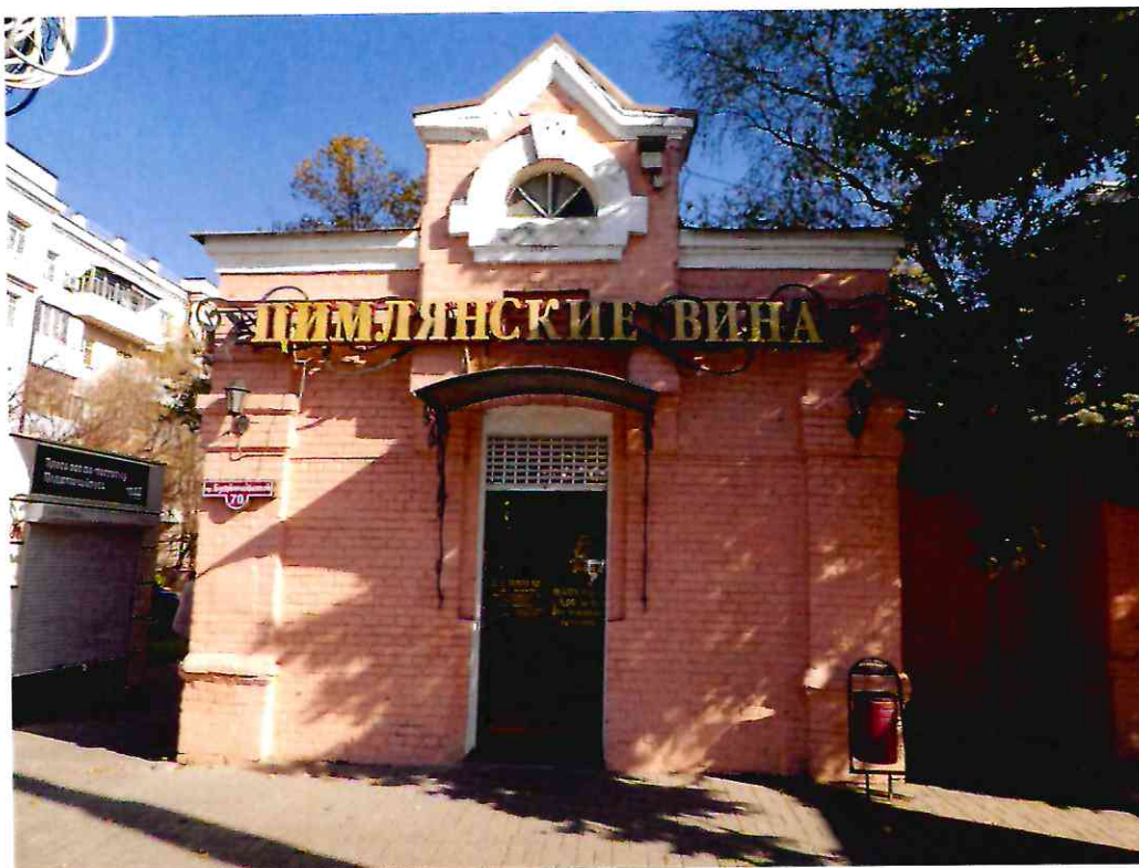
35. Общий вид северного фасада литера Е, входящего в состав Объекта.
