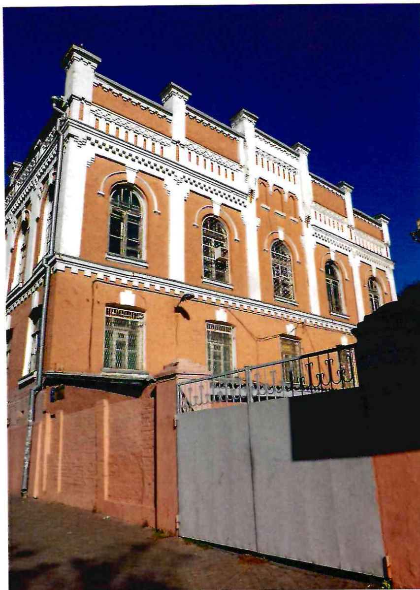
3. Общий вид южного фасада литера А, входящего в состав Объекта
