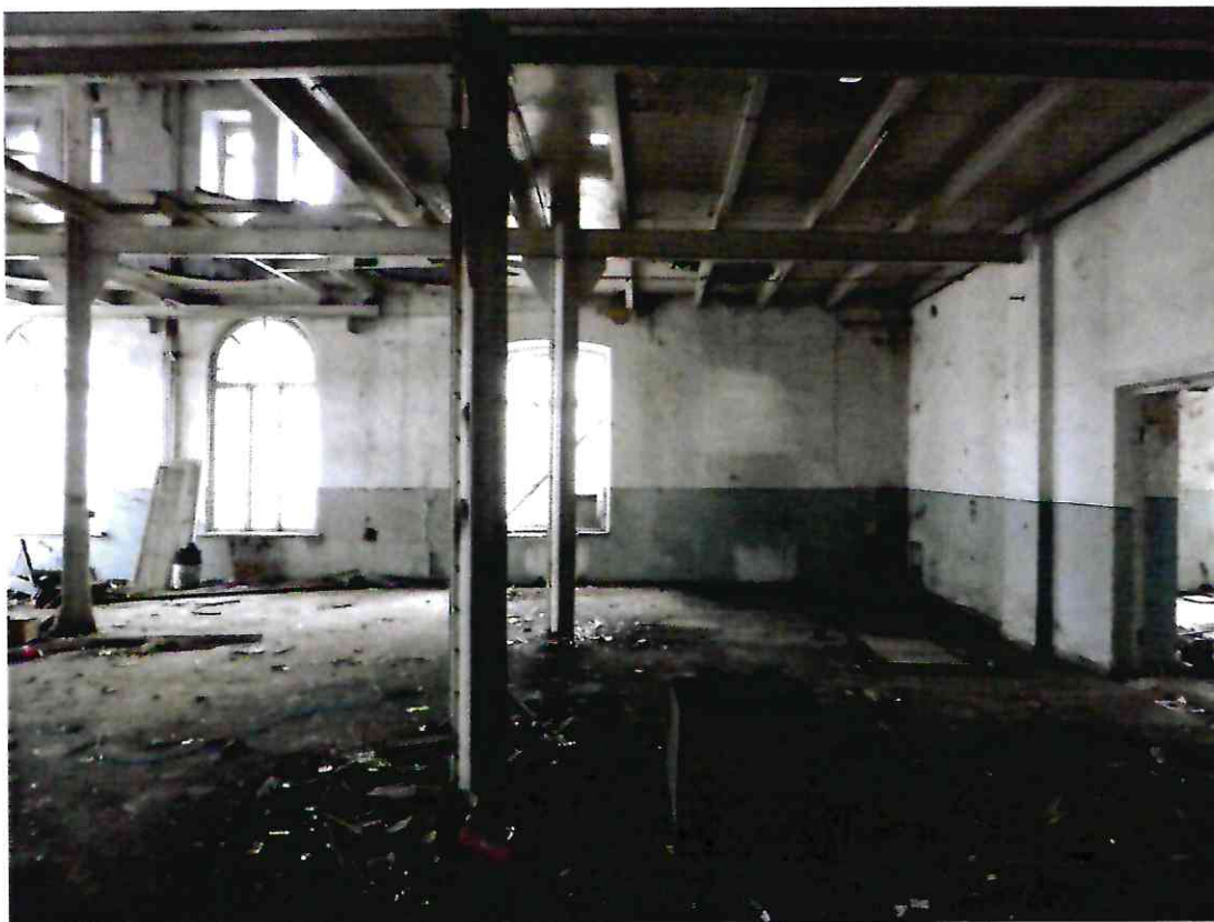
21. Помещение 2-го этажа литера А, входящего в состав Объекта.
