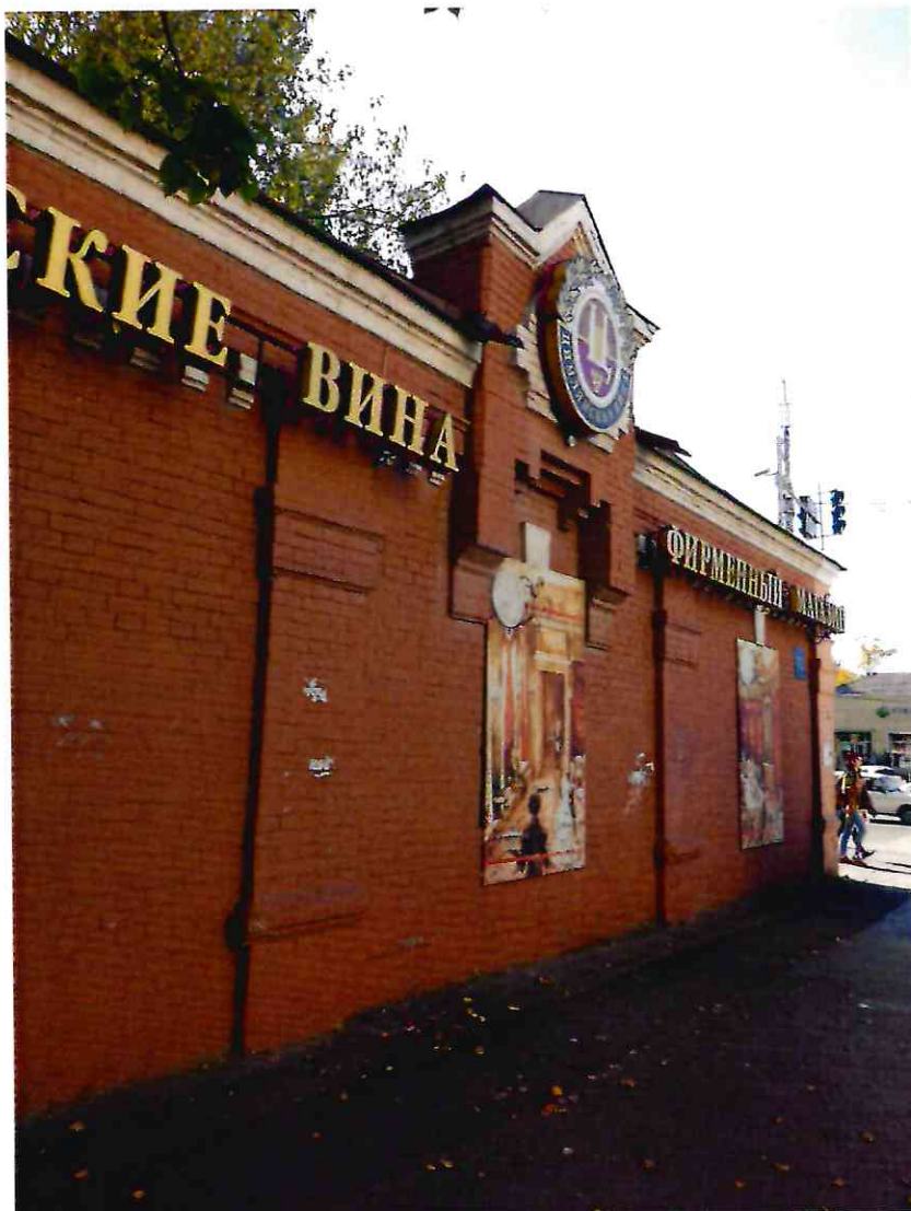
36. Общий вид северного фасада литера Е, входящего в состав Объекта.
