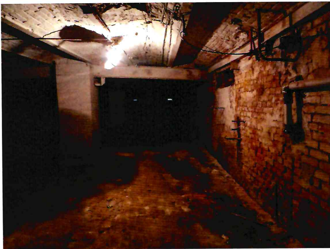
18. Помещение подвала литеры А, входящего в состав Объекта.
