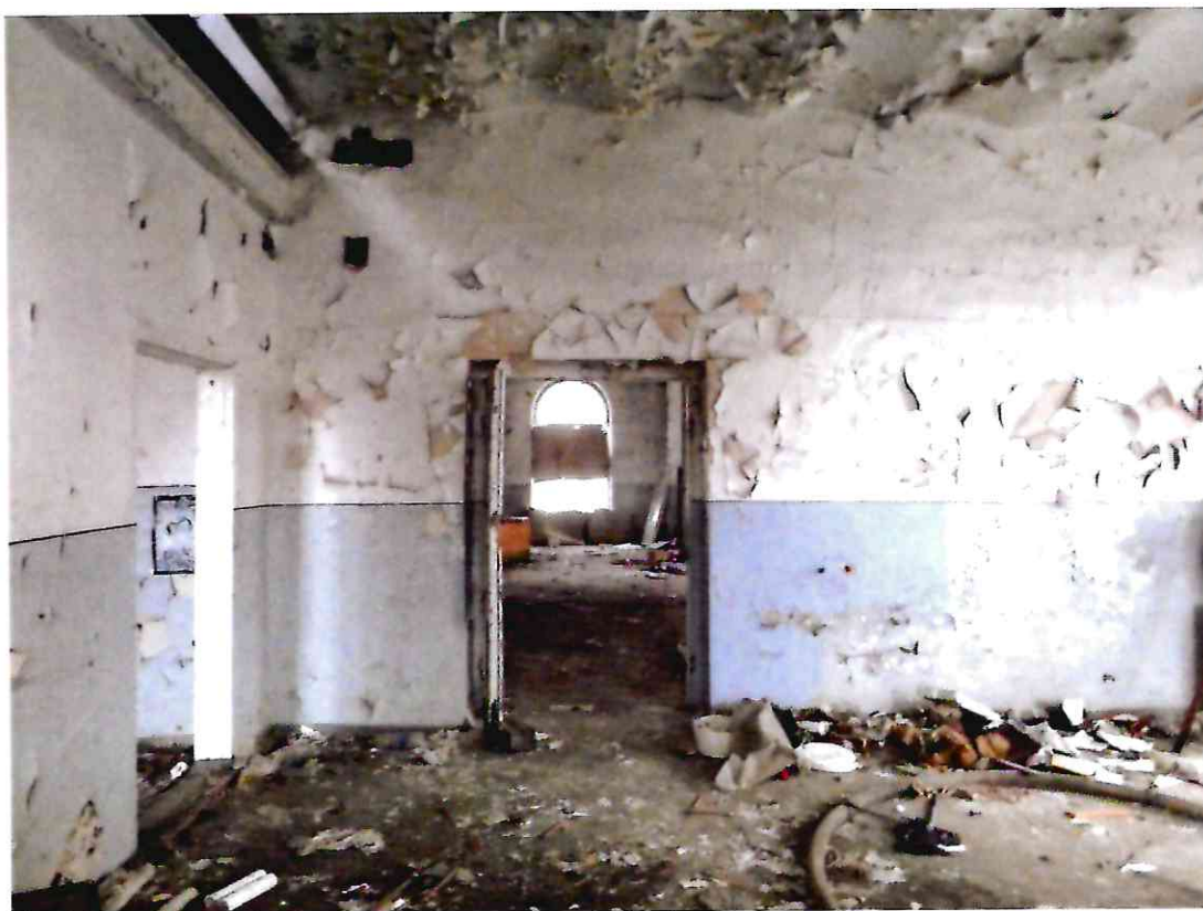
24. Помещение 2-го этажа литера А, входящего в состав Объекта.
