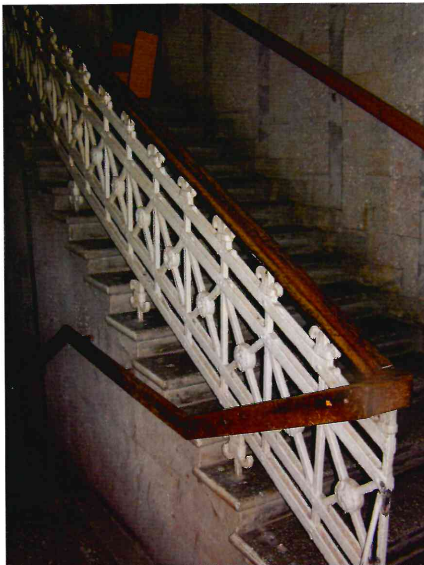
33. Внутренняя междуэтажная лестница литера А, входящего в состав Объекта.
