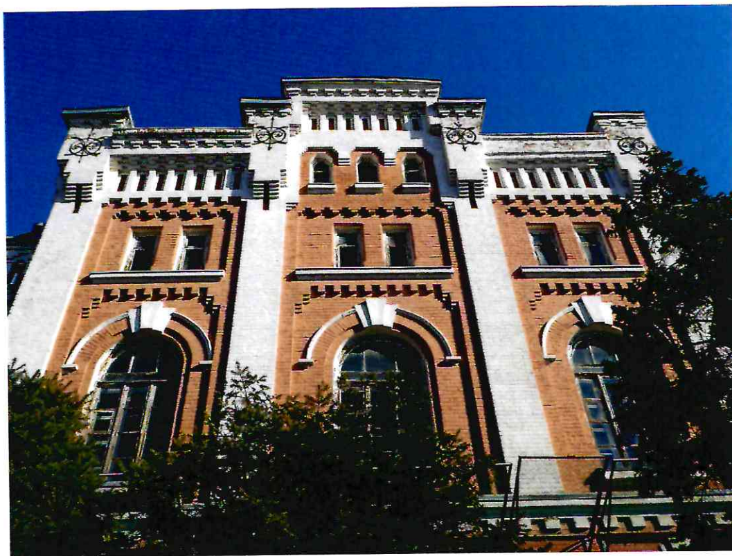
4. Раскреповка западного фасада литеры А, входящего в состав Объекта.
