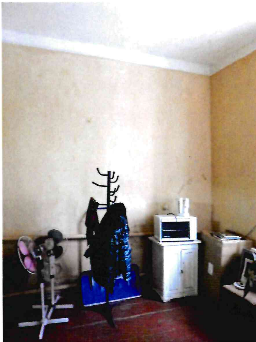
49. Помещение охраны литеры Л, входящего в состав Объекта.
