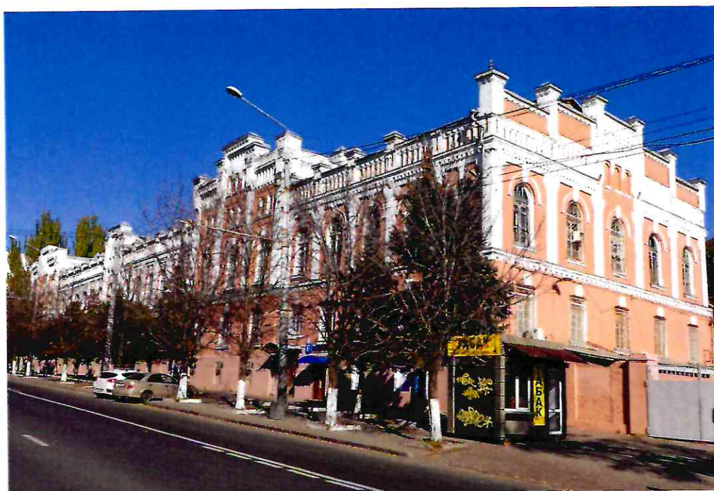
2. Вид литера А, входящего в состав Объекта с юго-запада.
