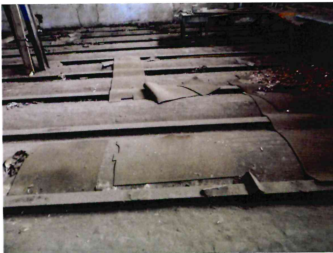
32. Балки перекрытия в помещении чердака литера А, входящего в состав Объекта.
