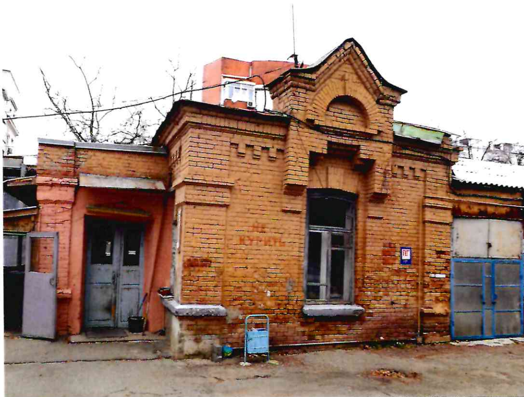
47. Общий вид южного фасада литера Л, входящего в состав Объекта.
