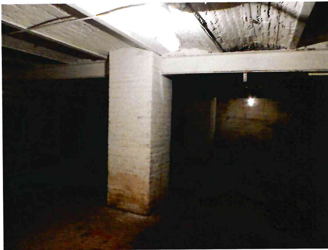
17. Конструкции перекрытия помещения подвала литеры А, входящего в состав Объекта.
