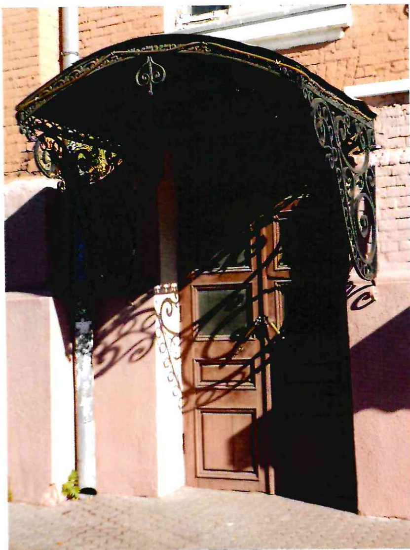
6. Козырек крыльца западного фасада литеры А, входящего в состав Объекта.
