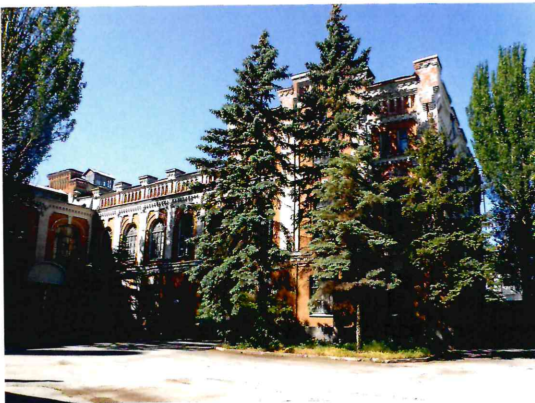
11. Вид с северо-востока литеров А, А1, входящих в состав Объекта.
