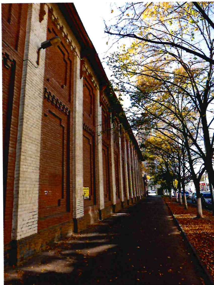
37. Общий вид северного фасада литера Ж, входящего в состав Объекта.
