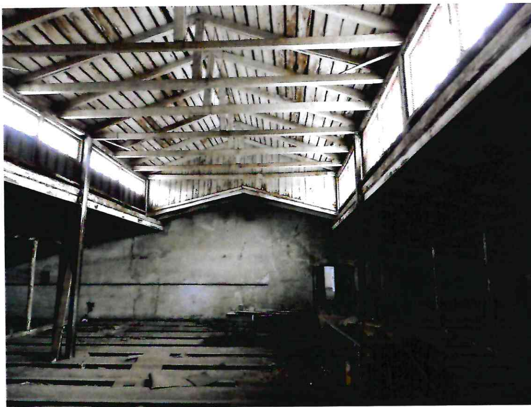
29. Помещение чердака, стропильные конструкции крыши литеры А, входящего в состав Объекта.
